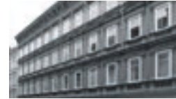
DACHBODENAUSBAU HANGLÖSSGASSE Wohnbau Wien
