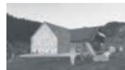
YBBSTALER- HÜTTE Alpinbau Göstling an der Ybbs
