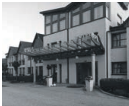
Kernsanierung, Fassadengestaltung und Interior Design
