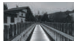
BRÜCKE LAABEN Öffentlicher Bau Brand-Laaben
