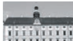
FASSADENSANIERUNG AMALIENTRAKT Öffentlicher Bau Wien
