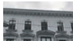
DACHBODENAUSBAU MILLERGASSE Wohnbau Wien
