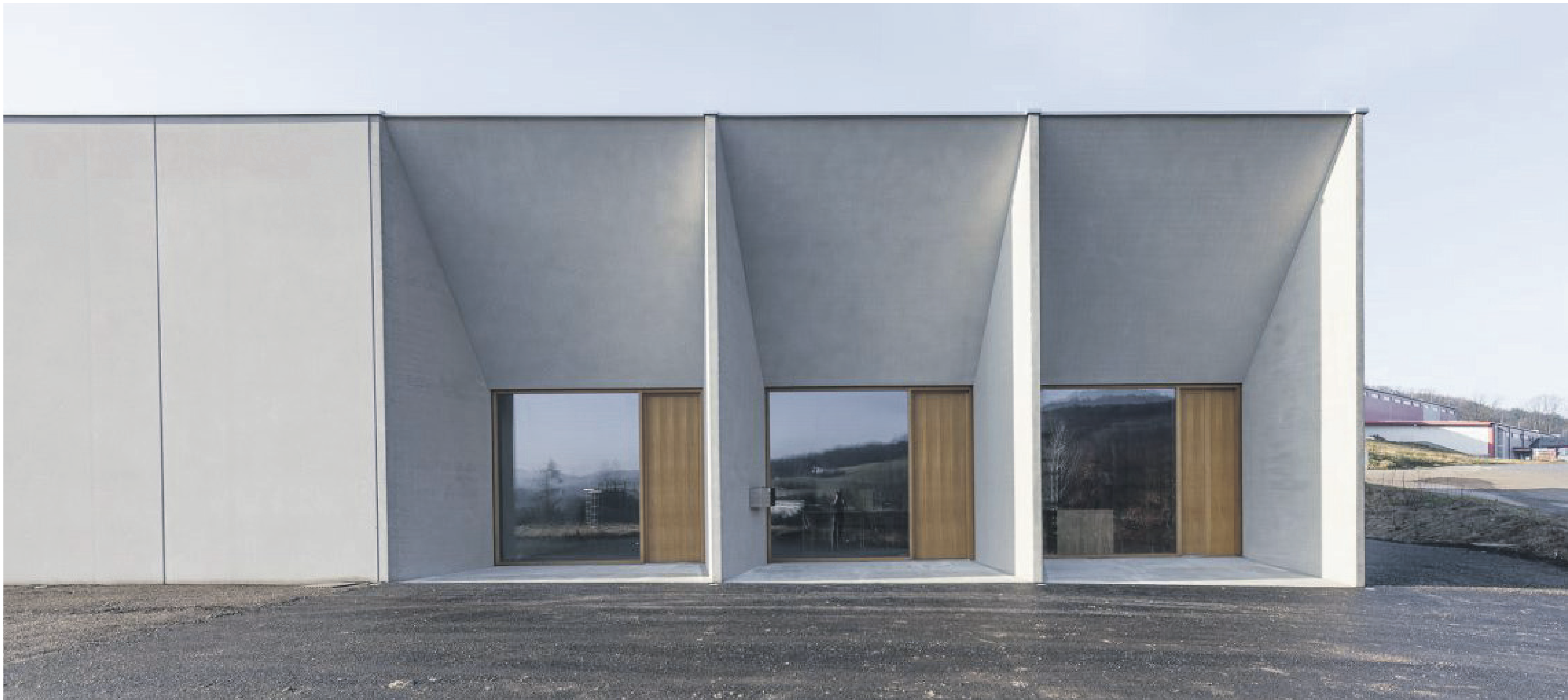
Sichtbeton, sandgestrahlte Betonfertigteile, Besenstrich, Eichenholzportale
