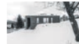
EINFAMILIENHAUS FAMILIE S. Wohnbau Brand-Laaben
