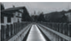
BRÜCKE LAABEN Öffentlicher Bau Brand-Laaben
