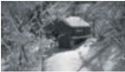
EINFAMILIENHAUS FAMILIE H. Wohnbau Brand-Laaben
