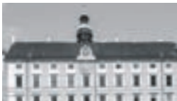
FASSADENSANIERUNG AMALIENTRAKT Öffentlicher Bau Wien
