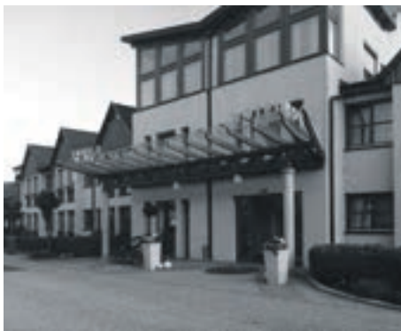
Kernsanierung, Fassadengestaltung und Interior Design
