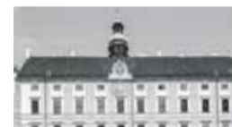
FASSADENSANIERUNG AMALIENSTRASSE Öffentlicher Bau Wien
