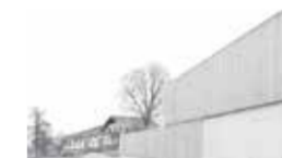
BAUHOF LAABEN Gewerbe Brand-Laaben
