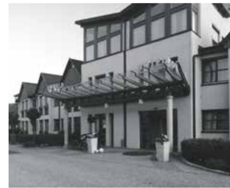
Kernsanierung, Fassadengestaltung und Interior Design
