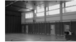
TURNHALLE KAUMBERG Schulbau Kaumberg
