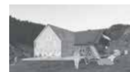
YBBSTALER- HÜTTE Alpinbau Göstling an der Ybbs
