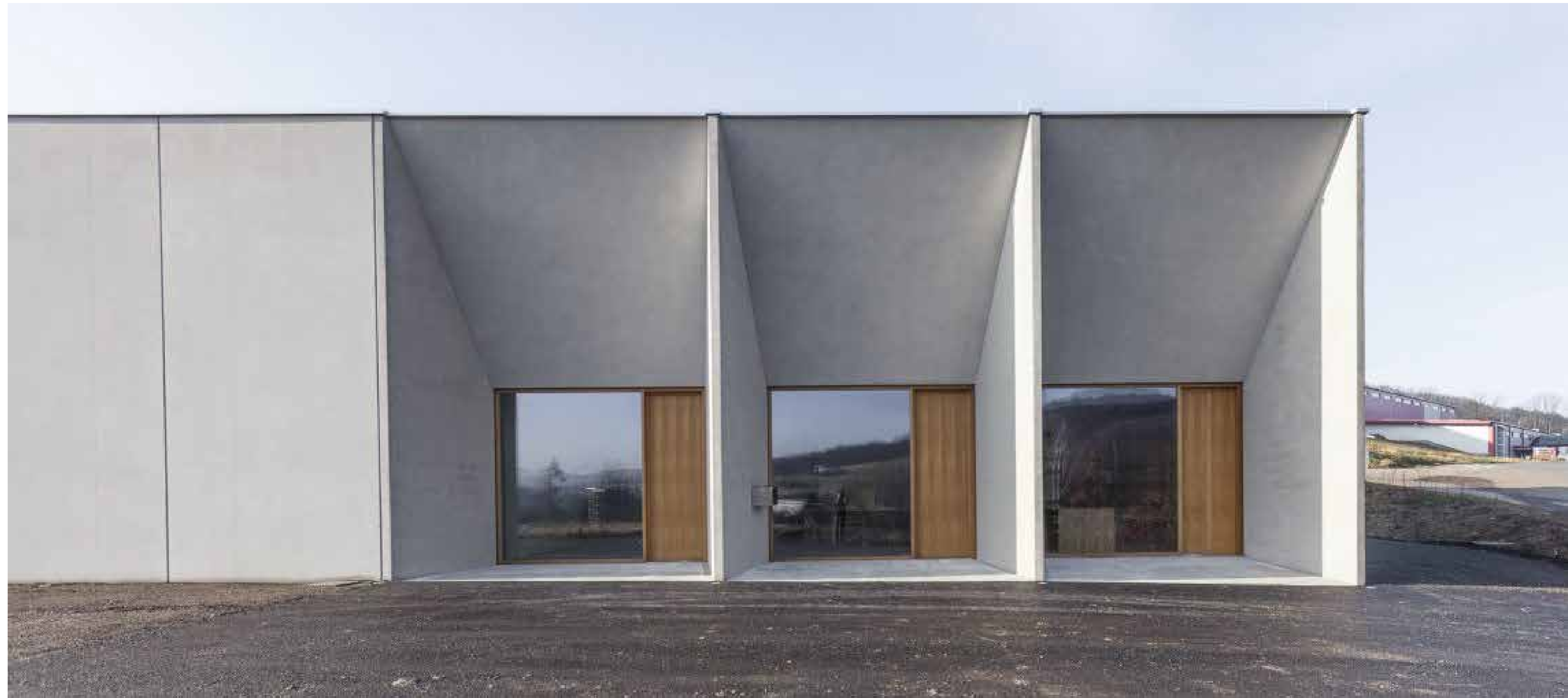
Sichtbeton, sandgestrahlte Betonfertigteile, Besenstrich, Eichenholzportale
