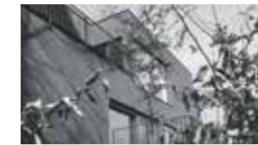
EINFAMILIENHAUS FAMILIE B. Wohnbau Neulengbach
